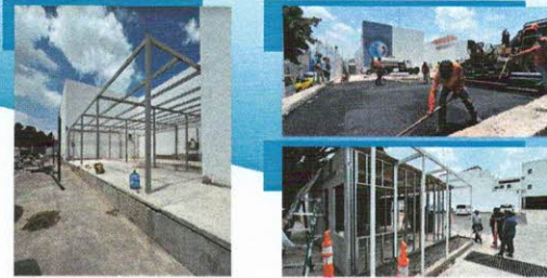
Construcción de estacionamiento y cubierta tipo bodega para archivo inactivo.
