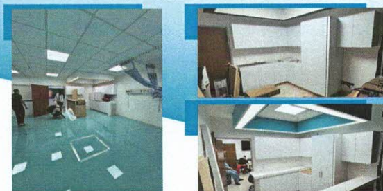
AVANCE PARCIAL DEL SUMINISTRO E INSTALACION DE CENTRALES DE ENFERMERIA
