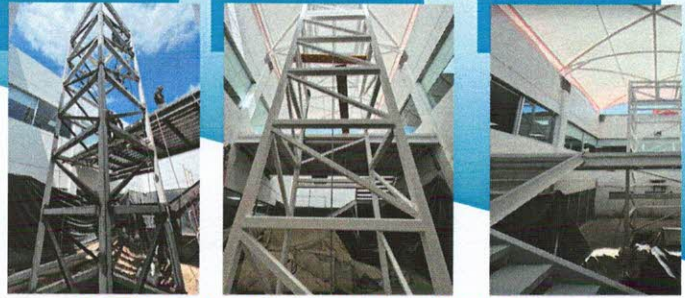
Construcción de cimentación y estructura para elevador panorámico. Construcción de escaleras para intercomunicación entre planta baja y alta. Andador de comunicación en planta alta de las dos áreas de consulta.
