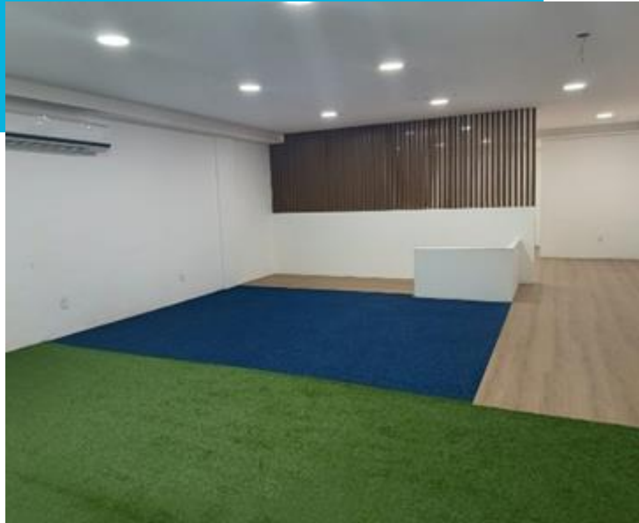
CONCLUSIÓN DE TRABAJOS EN LA RENOVACIÓN DEL ÁREA DE REHABILITACIÓN
